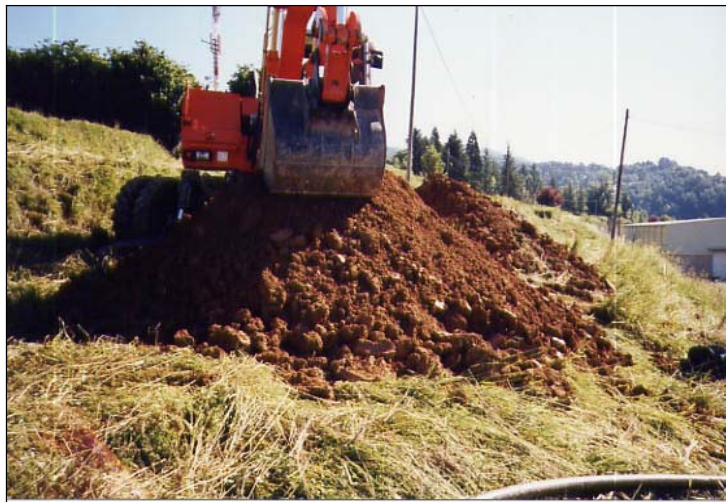
FOTOGRAFIA 14. Cala 5. Material remogut.
