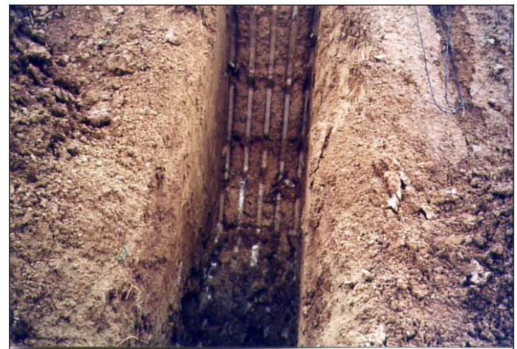
FOTOGRAFIA 3. Cala 1. Excavació de la cala.
