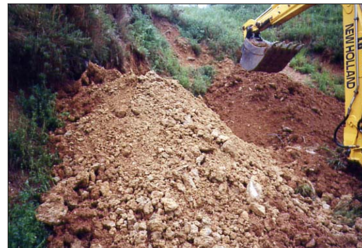
FOTOGRAFIA 5. Cala 2. Material remogut.
