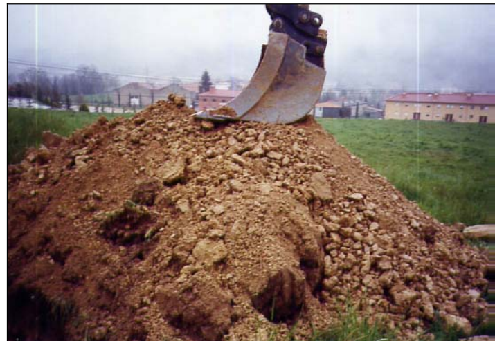
FOTOGRAFIA 8. Cala 3. Material remogut.
