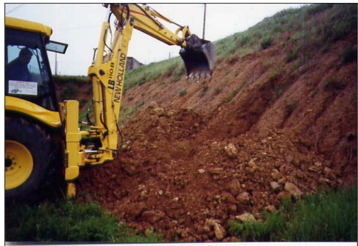
FOTOGRAFIA 2. Cala 1. Material remogut.
