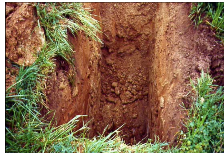
FOTOGRAFIA 12. Cala 4. Excavació de la cala.
