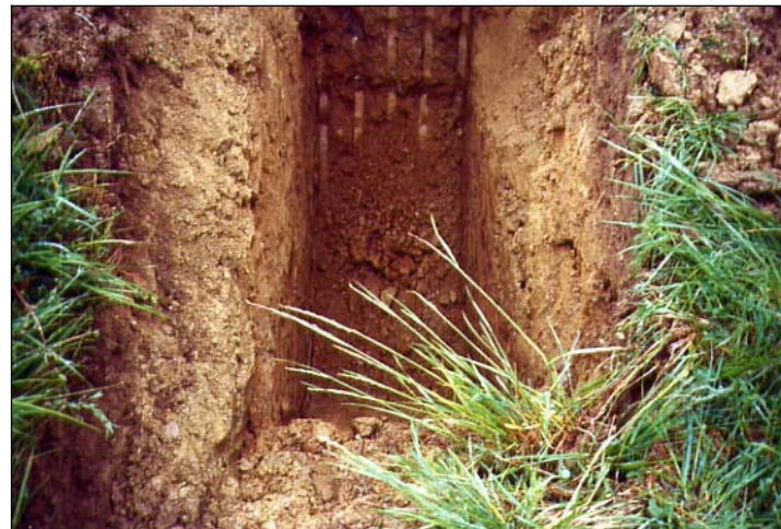
FOTOGRAFIA 9. Cala 3. Excavació de la cala.
