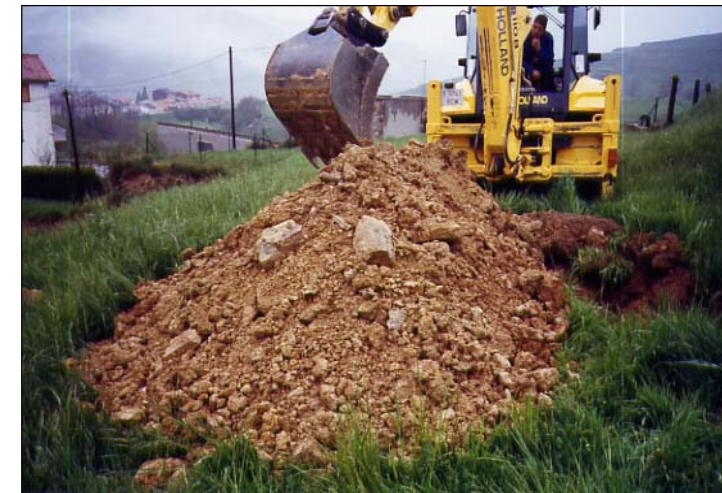
FOTOGRAFIA 11. Cala 4. Material remogut.
