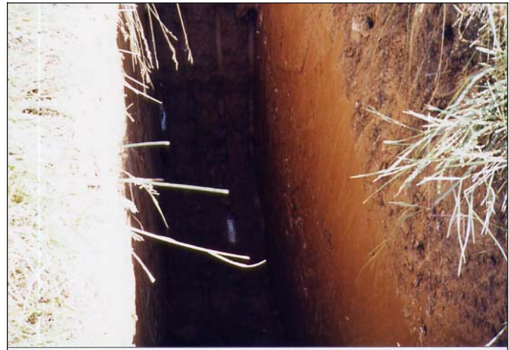
FOTOGRAFIA 15. Cala 5. Excavació de la cala.
