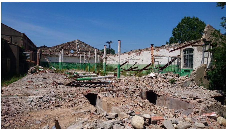
Estat previ: interior
