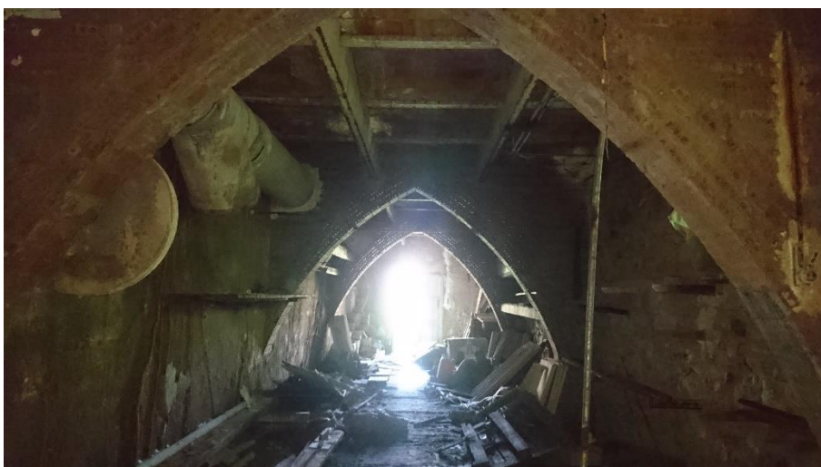
Estat previ: interior
