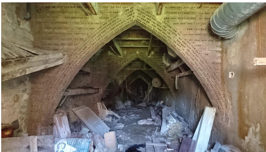
Estat previ: interior
