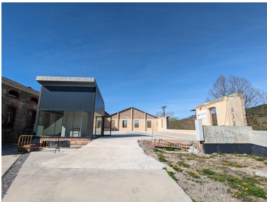
Estat actual: exterior
